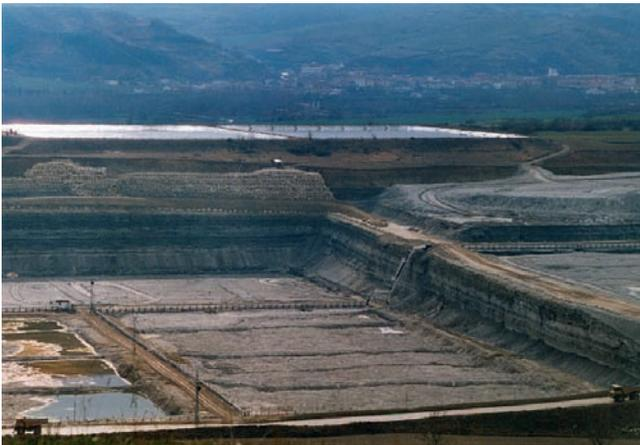
Minería por disolución. Santa Marta, Burgos. Preparación de las balsas en las que se disuelve el sulfato sódico (Glauberita) por inyección de agua, que se envía a la planta de cristalización, obteniéndose un sulfato prácticamente puro.
